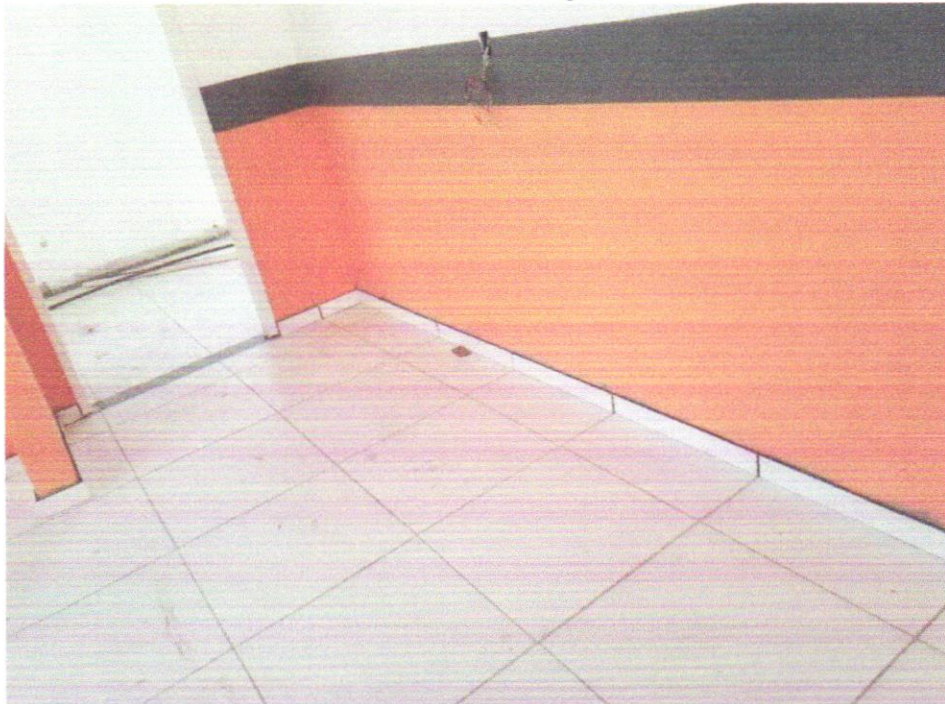
FOTO 04- APLICAÇÃO MANUAL DE PINTURA COM TINTA LÁTEX ACRÍLICA EM PAREDES, DEMÃOS. AF_06/2014 DEMÃOS. AF_06/2014
